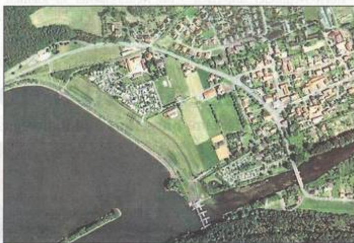
Neue Richtlinien beim Hochwasserschutz: Der Damm am Affolderner See wird um 80 Zentimeter erhöht.
