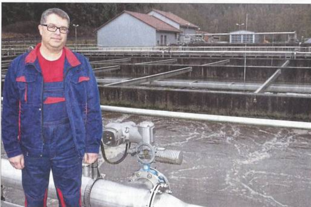
Phosphat-Belastung im Griff: In der Kläranlage bei Thalitter reicht zur Zufriedenheit ihres Leiters Mario Angenendt nach Versuchen eine Optimierung und Erweiterung der bisherigen Technik aus, um die erhöhten Anforderungen zu erfüllen. Foto: Wilhelm Figge
